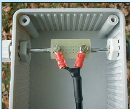
Bild 7: Der Anschluss des Koaxialkabels mit an Seele und Mantel angelöteten Quetschkabelschuhen an die Enden des Strahlerelements
