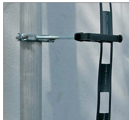
Bild 4: So kann eine Mastbefestigung aussehen. Fotos: DK7ZB
