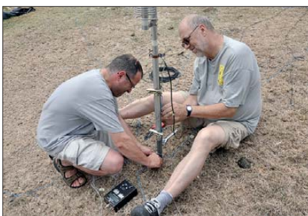
Berti, HB9SLO, und Herbert, HB9BOU, beim Errichten der Butternut-HF2V
