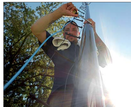
Veiko, DO9TT, beim Abbau der Masten
